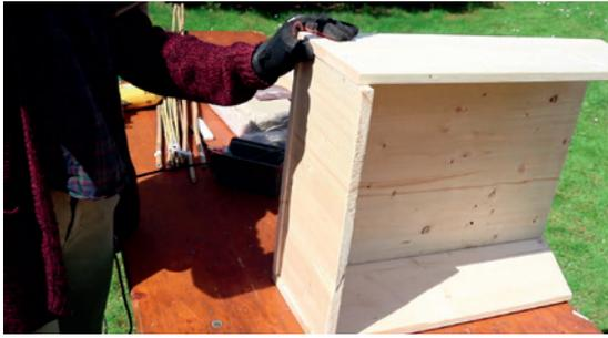
Als Nächstes bekommt dein Insektenhaus einen Boden. Hier werden jeweils vier Schrauben und Nägel gebraucht. Lege das Brett zwischen die Seitenwände und fixiere es mit Nägeln. Danach kannst du wieder vorbohren und die Schrauben in die Löcher festschrauben.
